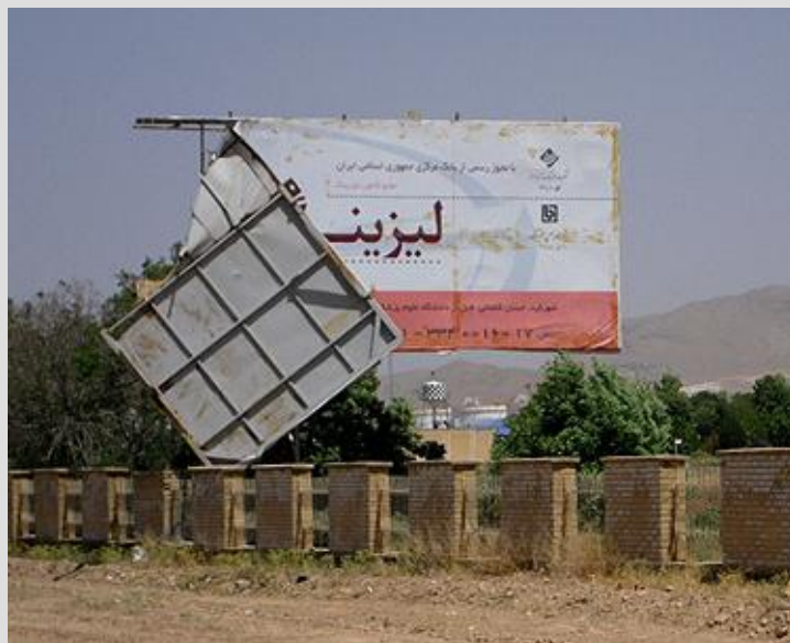
خرابی موضعی تابلو
